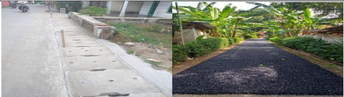
Perbaikan saluran/drainase dari U20 menjadi U30 dan pemasangan platdeker Di Gang 4 dan Pengaspalan jalan seluas 303,75 m di RT. 3. RW 2
