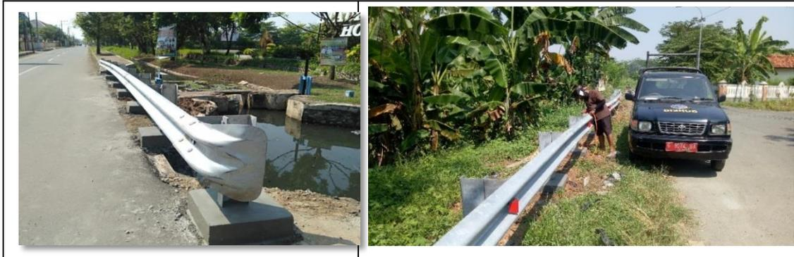
**Gambar 3.98 Pemasangan Guardrail di Kramat Sari dan Pasar Kuripan Baru**
