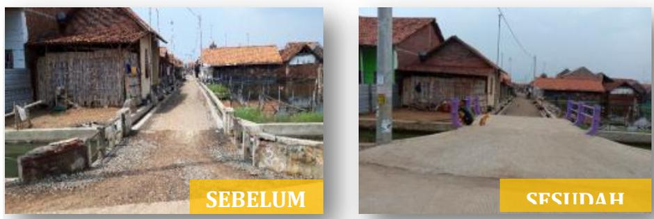
**Gambar 4.5 Dokumentasi Pembangunan Jembatan, Plat deker dalam rangka Peningkatan Kualitas Drainase**
