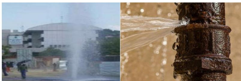
**Gambar 2.8 Kebocoran pada pipa penyebab kehilangan fisik**
