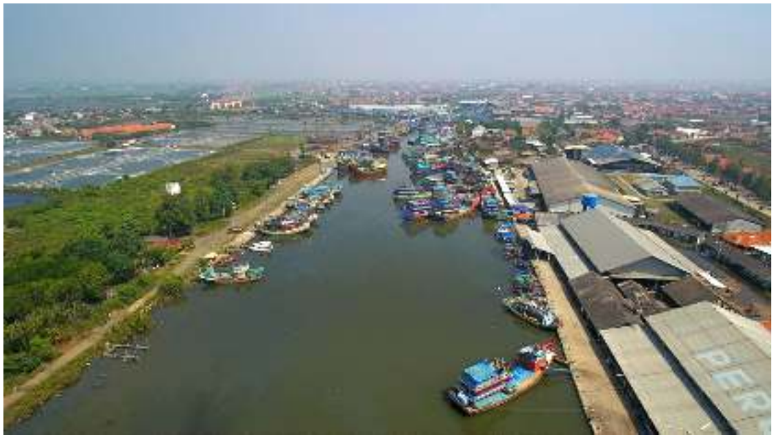
Gambar 2.4 Gedung TPI dan Kolam Pelabuhan PPN Pekalongan
