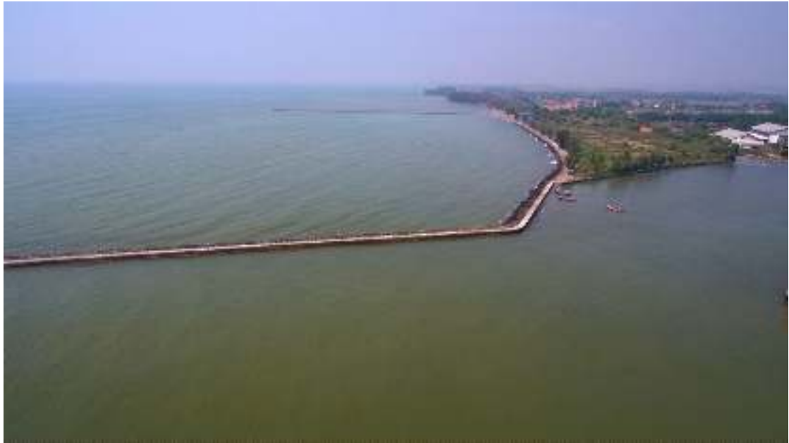
Gambar 2.10 Breakwater Sisi Timur PPN Pekalongan
