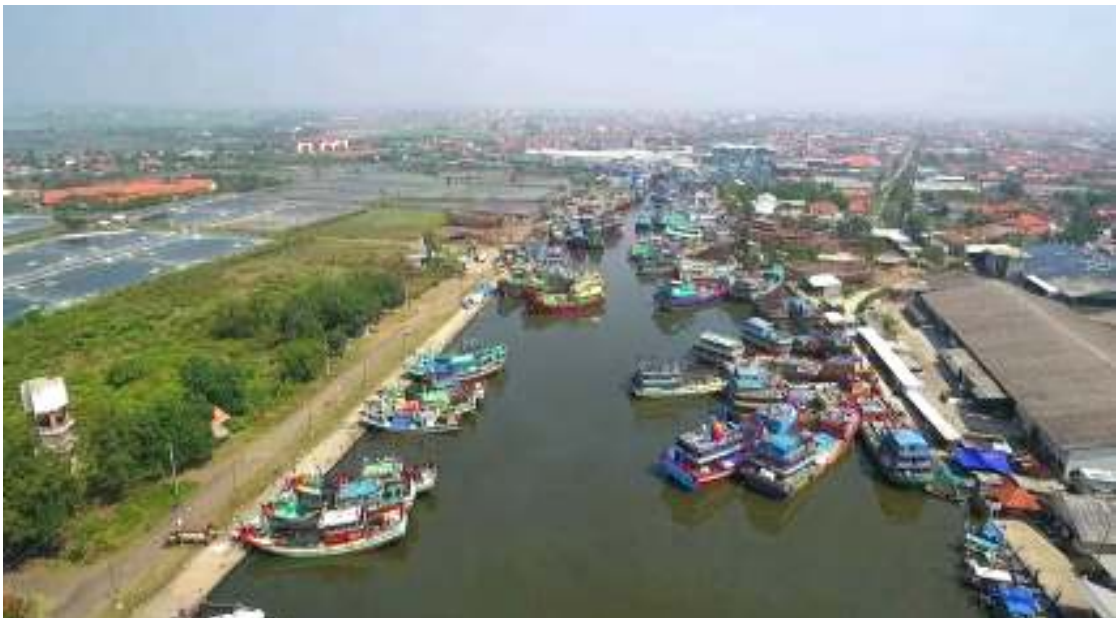
Gambar 2.8 Dermaga Sisi Barat dan Timur (PPN) Pekalongan
