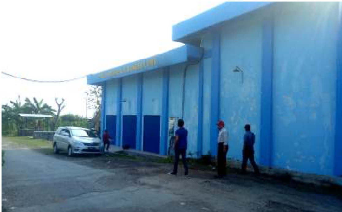
Gambar 2.20 Stasiun Pompa Air Banger Lama
